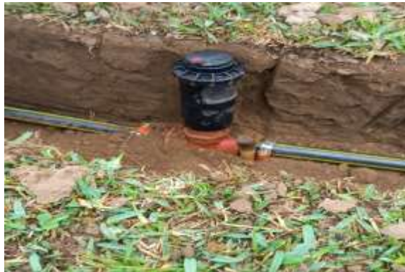
Figura 7. Instalación del aspersor emergente POP-UP Hunter ¾" en la línea de distribución.
