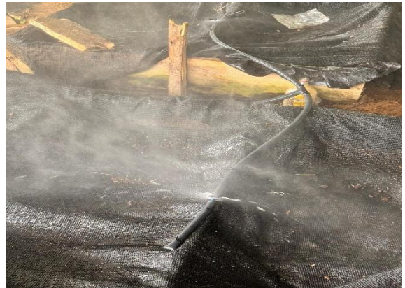
ILUSTRACIÓN 8: RIEGO POR MICROASPERSIÓN
