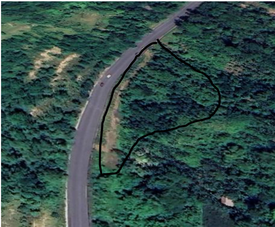
Figura 20. Área de talud de la vía, proceso de pérdida de masa de suelo (2024).
