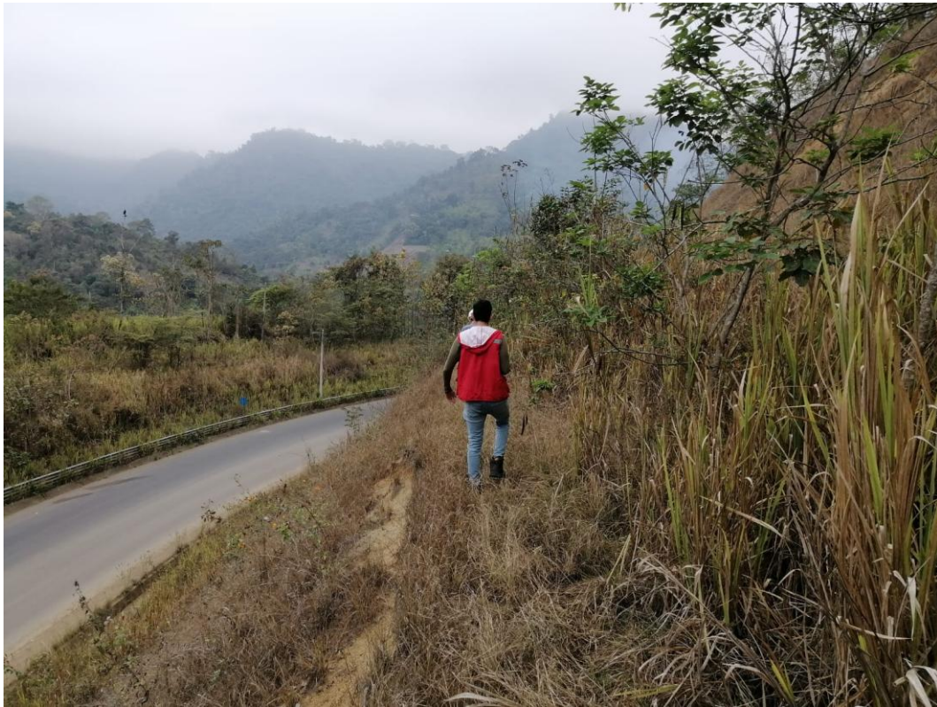
Figura 14. Terraceo del talud superior de la vía en óptimas condiciones
