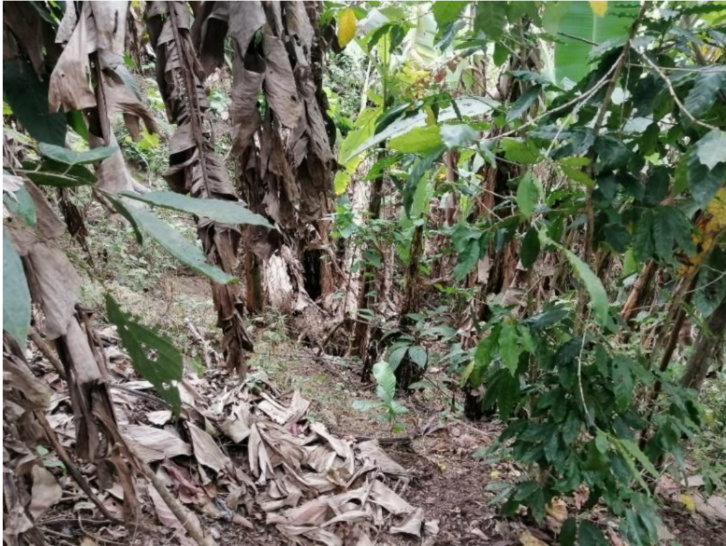
Figura 39. Vegetación de ciclo corto en el talud de la vía
