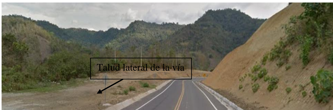
Figura 23. Condiciones del talud de la vía (2015)
