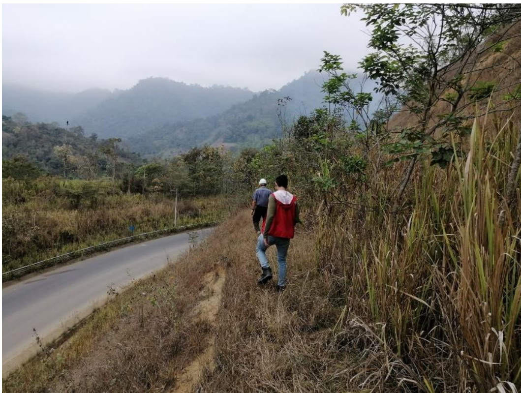
Figura 42. Terraceo del talud superior de la vía en buenas condiciones
