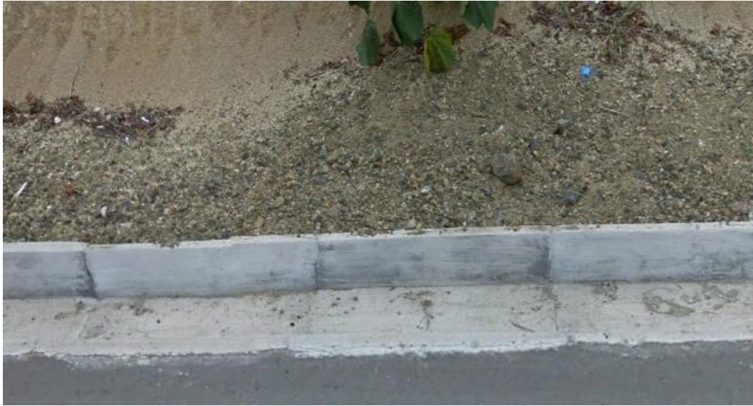
Figura 15. Cunetas, drenaje lateral de la vía (2015)
