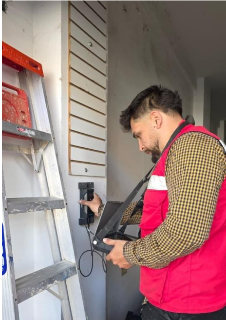
Ensayo de columna con el esclerómetro.
