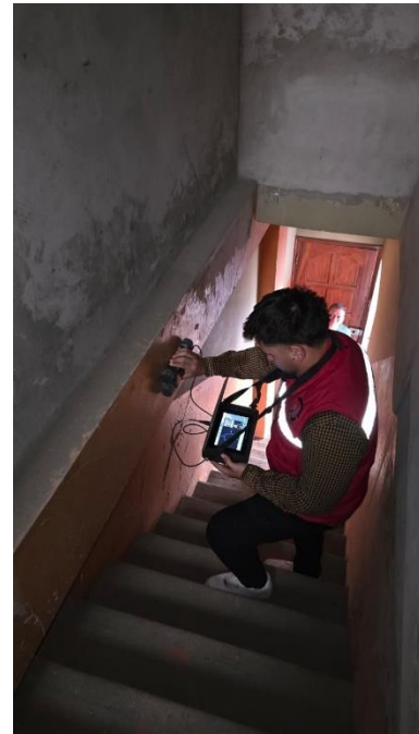
Ensayo de viga con el pachómetro.
