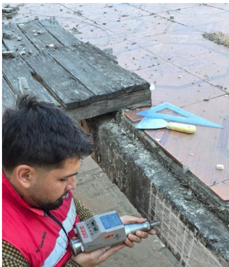
Ensayo de viga con el esclerómetro.
