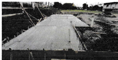
Ilustración 11 Piso fundido
