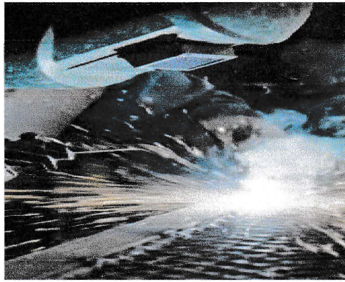
Ilustración 2 Aseguramiento de malla electrosoldada con electrodo revestido E6011
