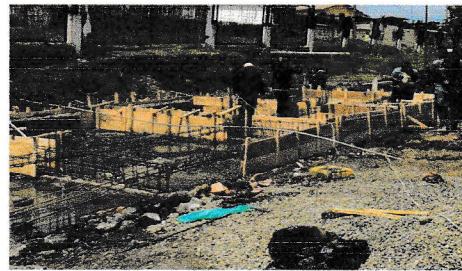
Ilustración 6 Encofrado
