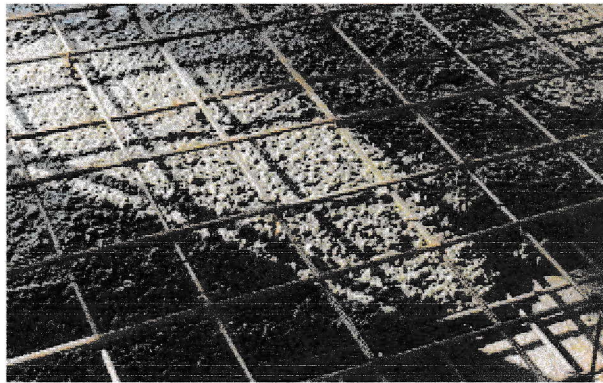
Ilustración 3 Recubrimiento de la malla electrosoldada
