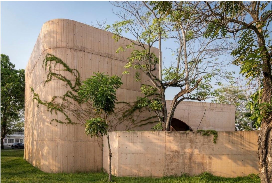
Figura 9. Fachada centro de desarrollo comunitario
