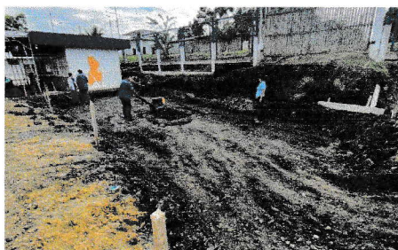
Ilustración 5 Cambio de suelo
