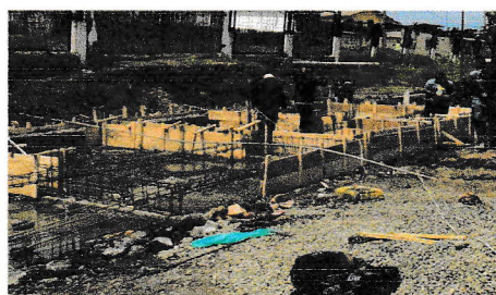
Ilustración 6 Encofrado
