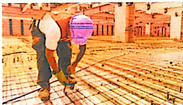
Ilustración 2 amarre de la malla
