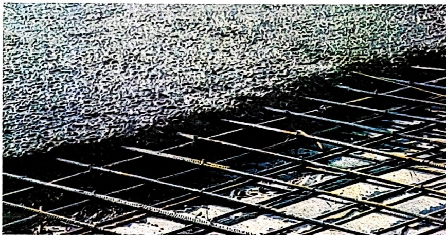
Ilustración 3 Recubrimiento de la malla electrosoldada.
