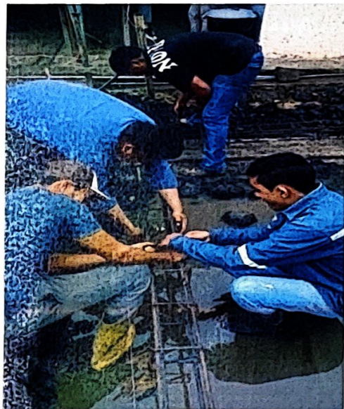
Ilustración 6 Ensamble de estructura de cimentación.
