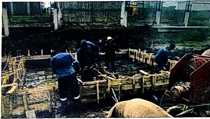
Ilustración 8 Fundición de hormigón.
