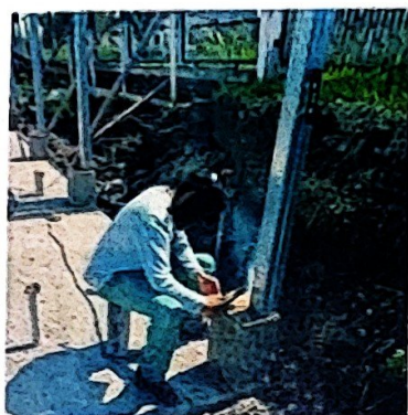
Ilustración 11 Fijación de parantes metálicos.
