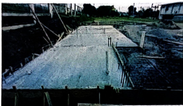
Ilustración 10 Piso fundido.
