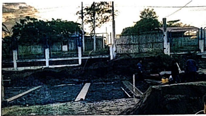
Ilustración 5 Construcción de replantillo.
