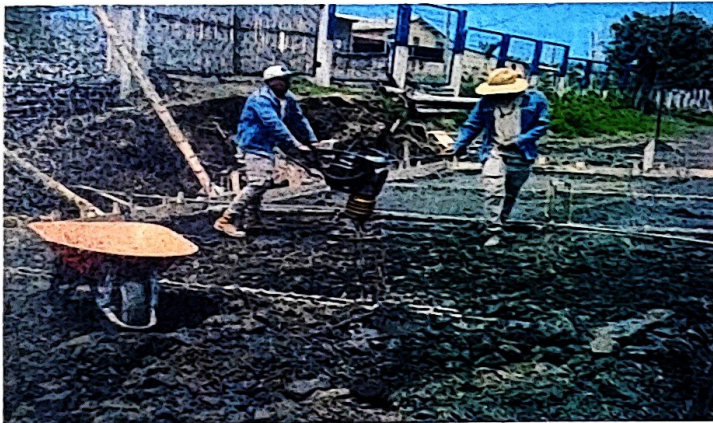
Ilustración 9 Compactación de bloques de pisos.
