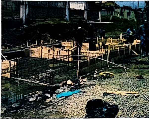
Ilustración 7 Encofrado.
