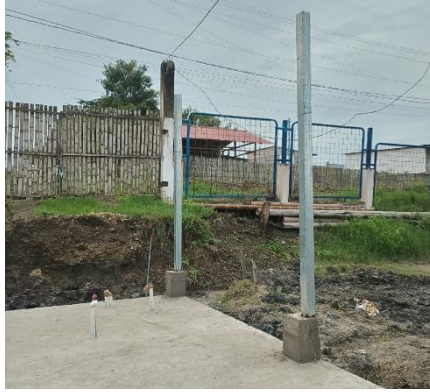
Ilustración 8. Montaje de la estructura
