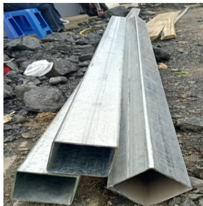
Ilustración 3. Adquisición del acero estructural
