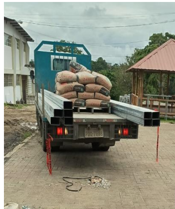
Ilustración 2. Adquisición del acero estructural
