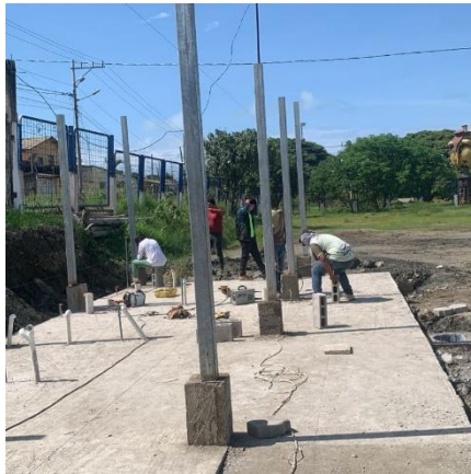
Ilustración 9. Montaje de la estructura
