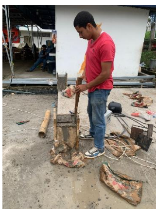
Ilustración 4. Preparación de la base para la columna
