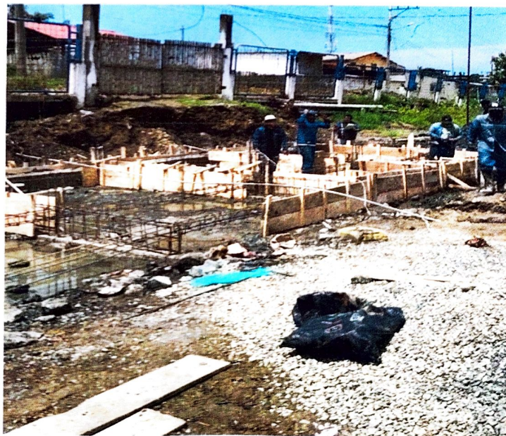
Anexo 2 Definición de bases para estructura
