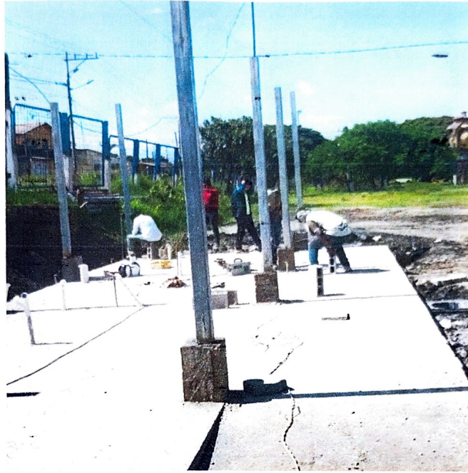
Anexo 3 Montaje de los parantes en las platinas y posterior soldadura
