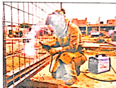
Ilustración 2 Puntos estratégicos de soldadura
