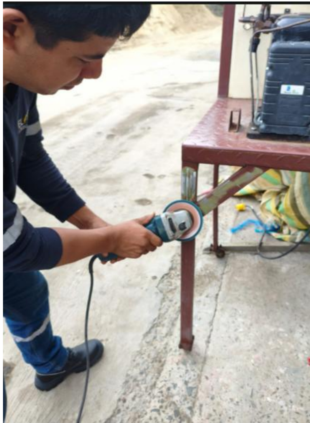
Anexo 5.2: Pulido superficial de toda la estructura metálica.
