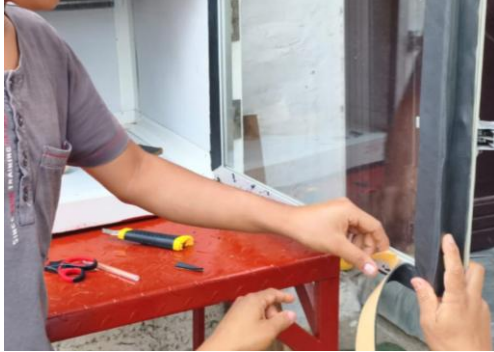
Figura 25 Cambio de aislante en cámara de conservación
