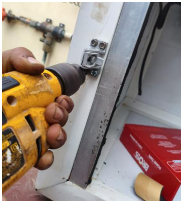
Anexo 5.6: Cambio de manijas de puertas de cámaras.
