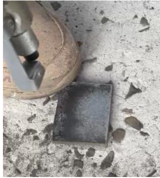
Ilustración 10 limpieza de acero
