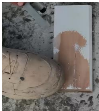
Ilustración 9 limpieza de madera
