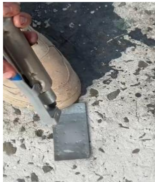
Ilustración 11 limpieza de galvanizado
