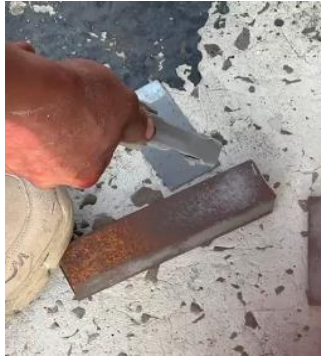
Ilustración 7 Limpieza de tubo de hierro negro
