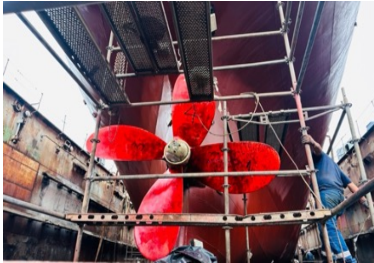
Ilustración 7: Prueba total de tinta penetrante
