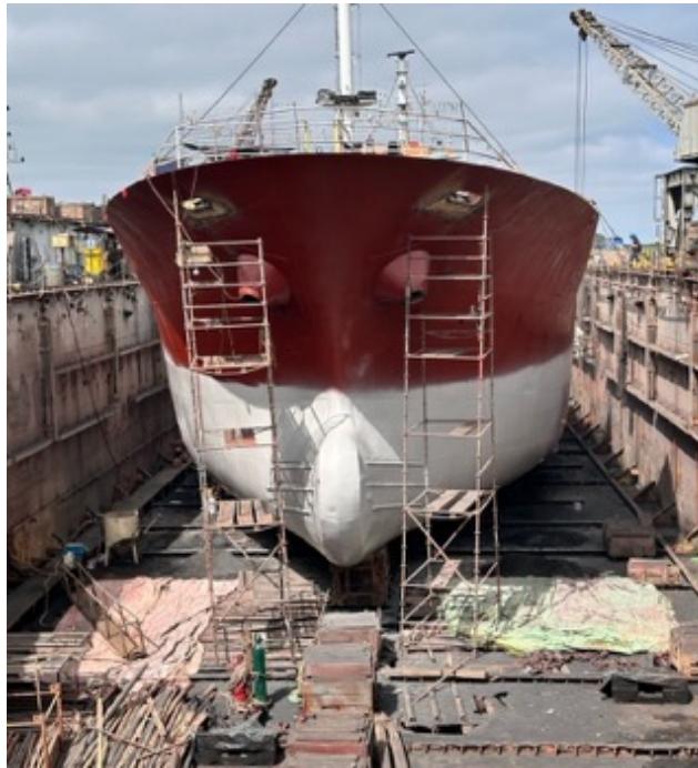
Ilustración 12: Aplicación de segunda capa de pintura en obra viva
