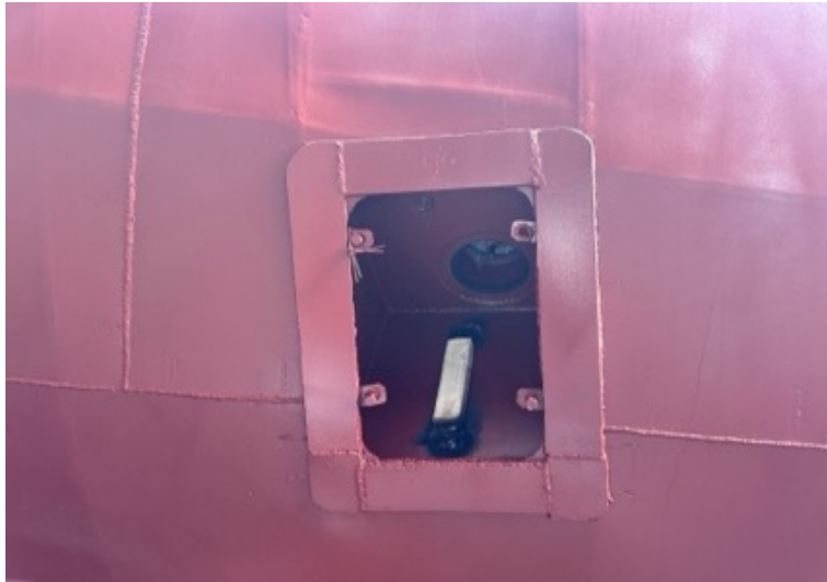
Ilustración 8: colocación de ánodos de sacrificio en las caja de mar del buque
