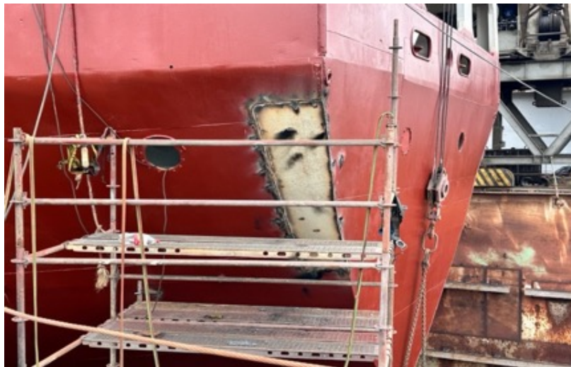
Ilustración 16: Cambio de acero naval en una sección específica.
