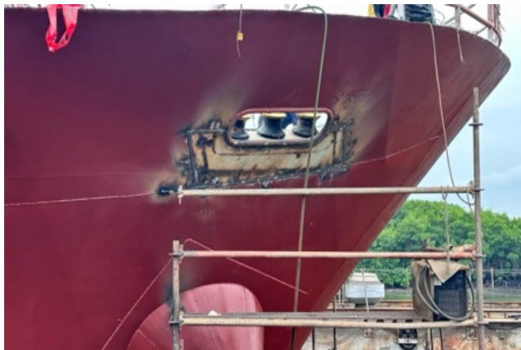
Ilustración 4: Remodelación de sección en cuadernas de proa
