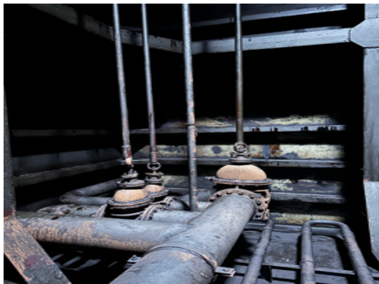
Ilustración 18: Sistema de bombas en parcelas.
