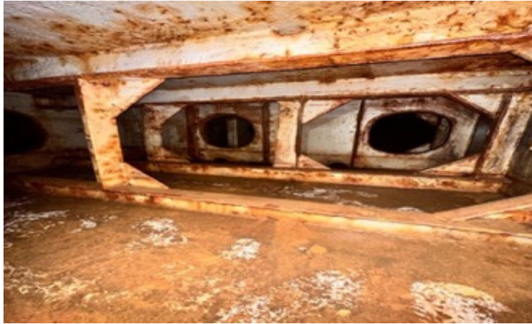
Ilustración 17: Tanques de lastre
