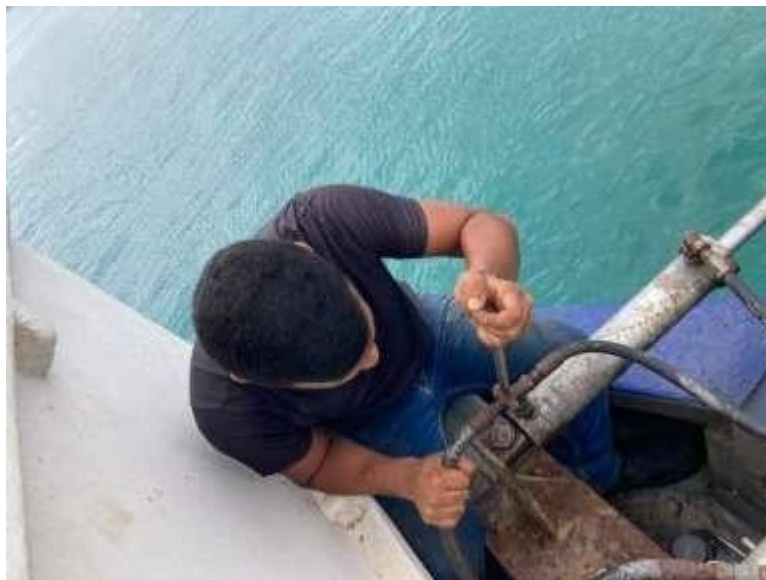
Ilustración 46 Desmontaje de gatos hidráulicos
