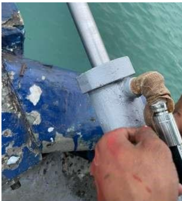
Ilustración 21 Recubrimiento con cinta engrasada
