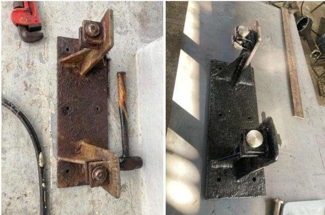
Ilustración 20 Antes y después del soporte de los gatos hidráulicos
