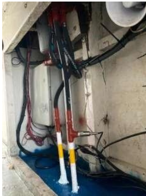
Ilustración 25 Conexiones nuevas en la salida del cuarto de máquinas
