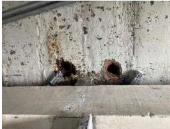
Ilustración 40 Huecos salientes de sala de máquinas
