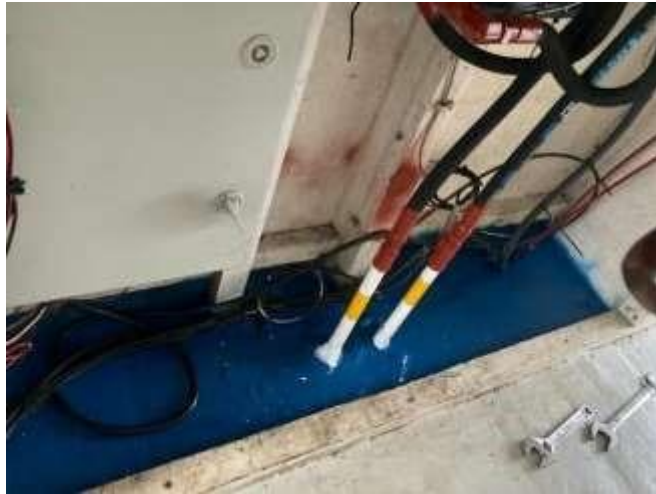
Ilustración 42 Adaptación de huecos más grandes para poder cambiar el tramo por tubería
