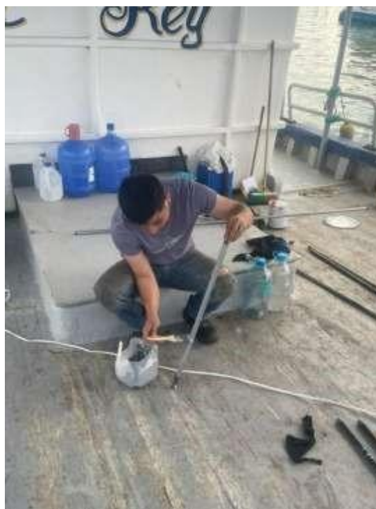
Ilustración 49 Pintado de tuberías, para mejor la resistencia a la corrosión
