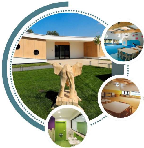
Figura 4: Collage de vistas exteriores e interiores del proyecto 1.
