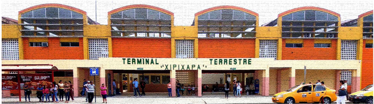
Terminal Terrestre de Jipijapa.
