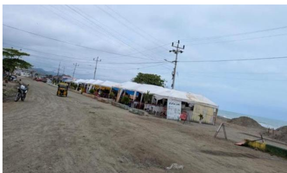
Ilustración 3 sobrepoblación de puestos informales en el borde costero/ Fuente: Malecón de Pedernales/ Autor: imagen elaborada por el tesista
