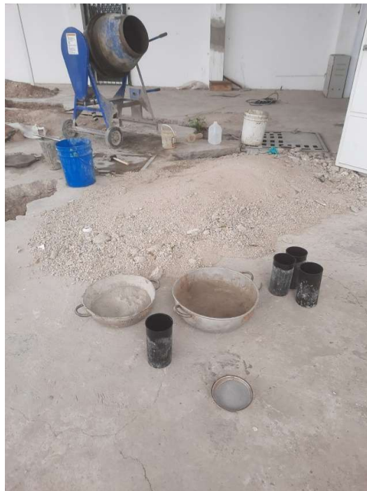
Anexo 4. Preparación del hormigón + cáscara de arroz
