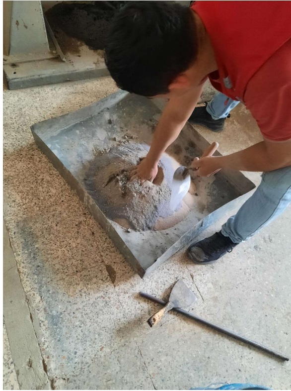
Anexo 3. Realización de la mezcla de hormigón + ceniza
