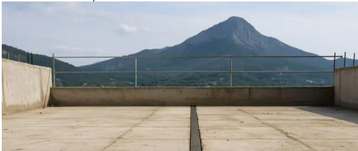
Juntas de dilatación o expansión
