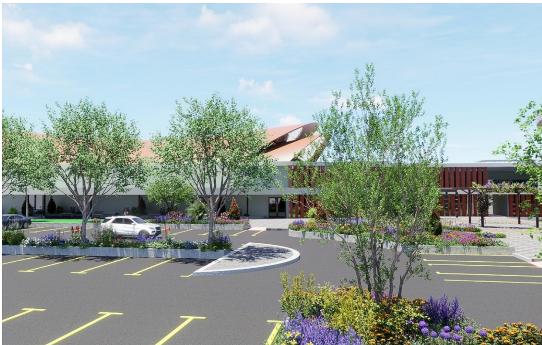
Figura 51 47: Área de estacionamientos
