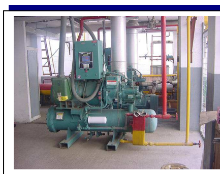
Fig. 3.21d: Equipos de cámaras: Compresores
