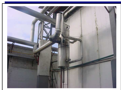
Fig. 4.38b.: Sistema de Refrigeración: Tubería
