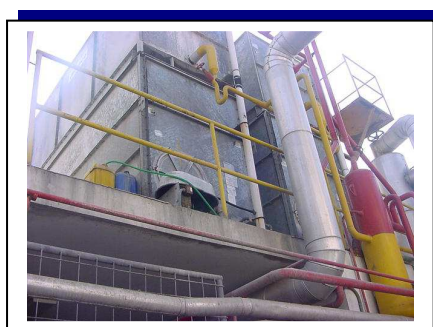
Fig. 3.21b: Equipos de cámaras: Torres de enfriamiento
