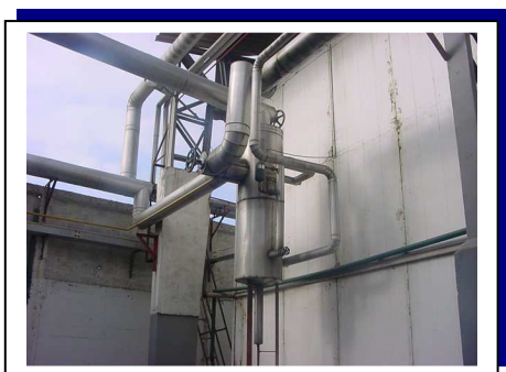
Fig. 3.21a: Equipos de cámaras: Tuberías
