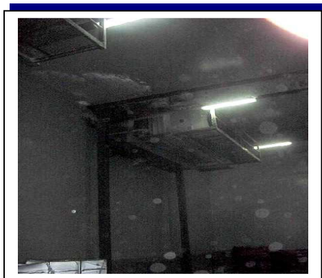
Fig.4.45: Parte interna de la cámara frigorífica
