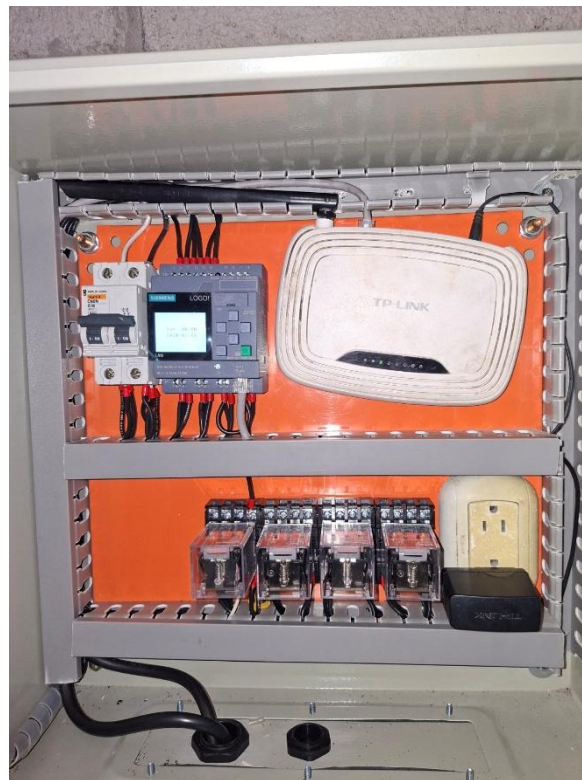
Ilustración 83 Imagen de la colocación del sistema en funcionamiento
