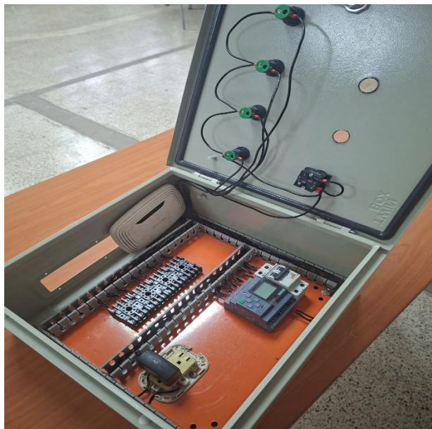
Ilustración 80 Instalación y fijación al tablero
