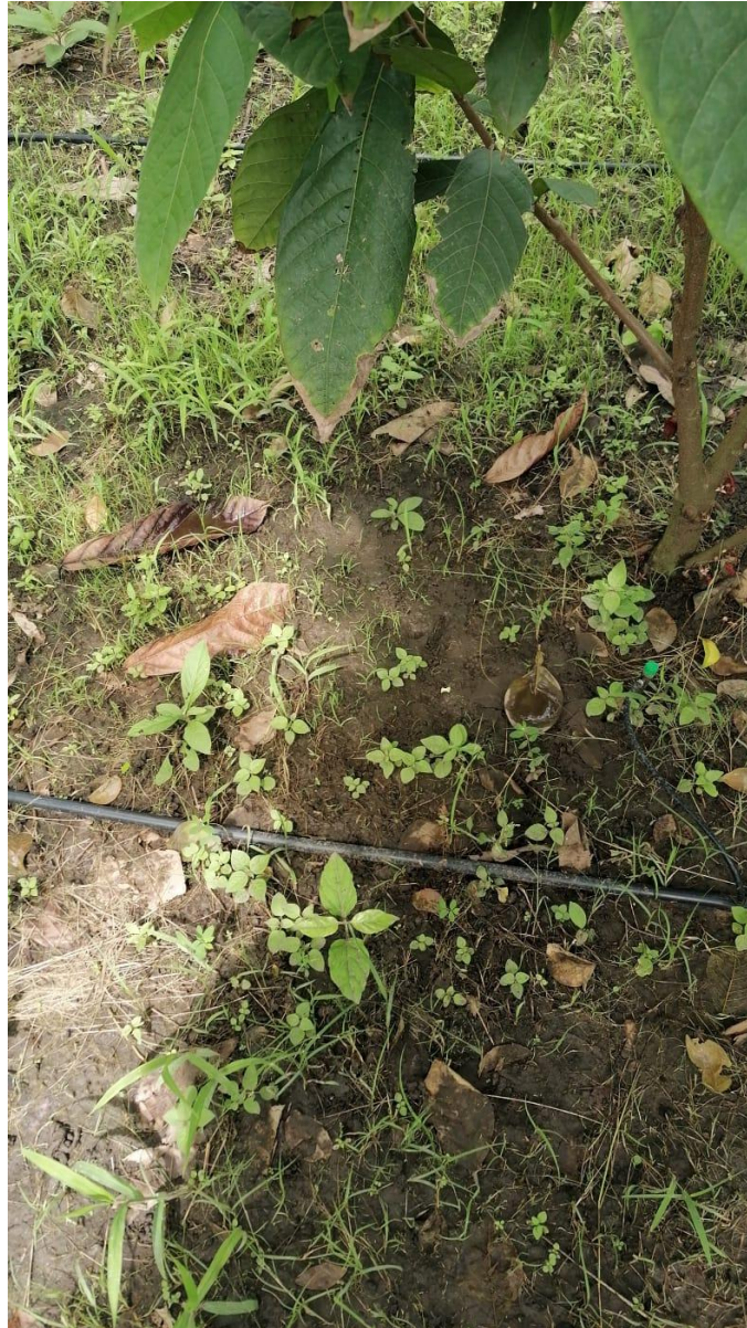
Ilustración 47. Fotos de las tuberías instaladas
