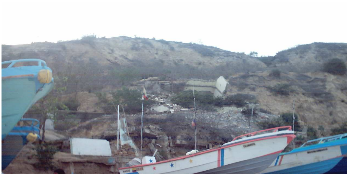
Zonas de riesgo por deslizamiento
