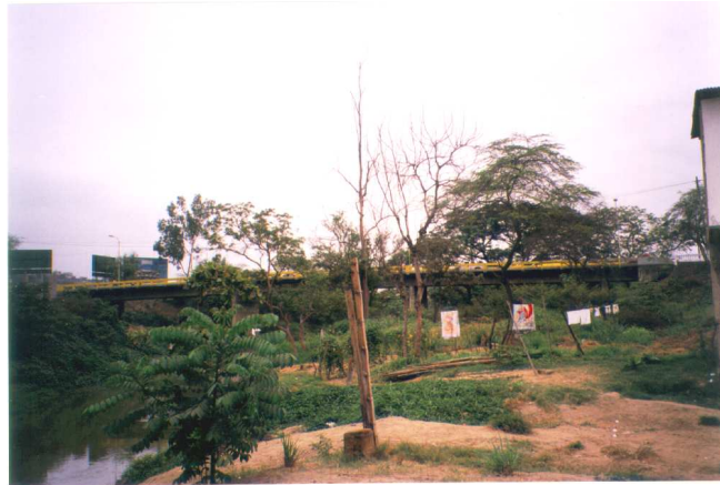
Vista del área de estudio incluido el Puente Velasco Ibarra
