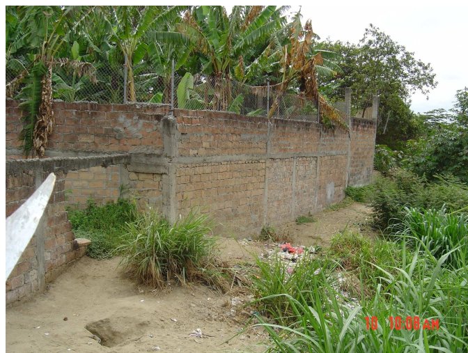
Prédios que invaden la margen del rio
