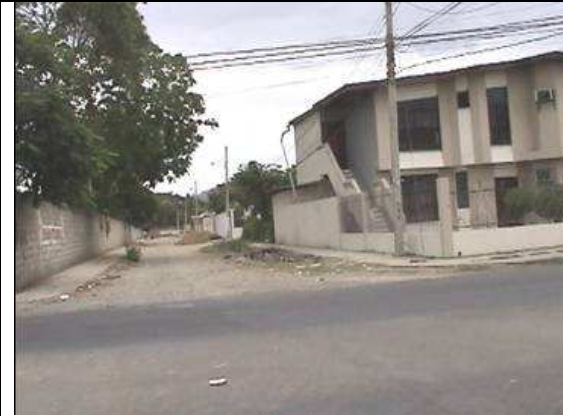
Otra calle de la parte oeste del barrio, en este caso existen aceras y bordillos, a la izquierda de la foto, tenemos un gran lote hasta el margen del río.
