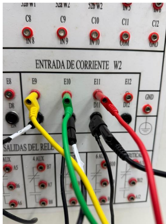
Figura 6 Entrada de corriente W2 del módulo sistema protección de transformadores relé GE multilin 345
