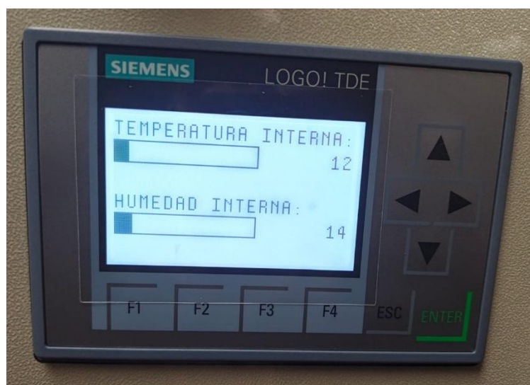
Figura 34. TDE #2 Temperatura y Humedad interna
