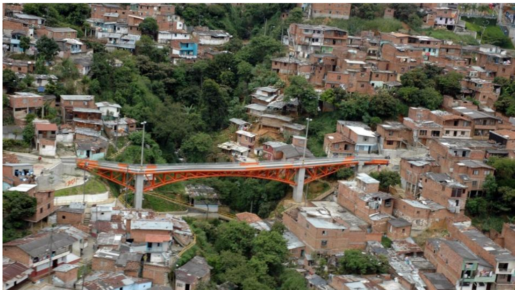
Figura 2. Puente mirador Andalucía – La Francia
