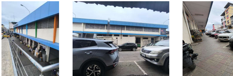
Fotos externas actuales del Mercado Central Municipal
