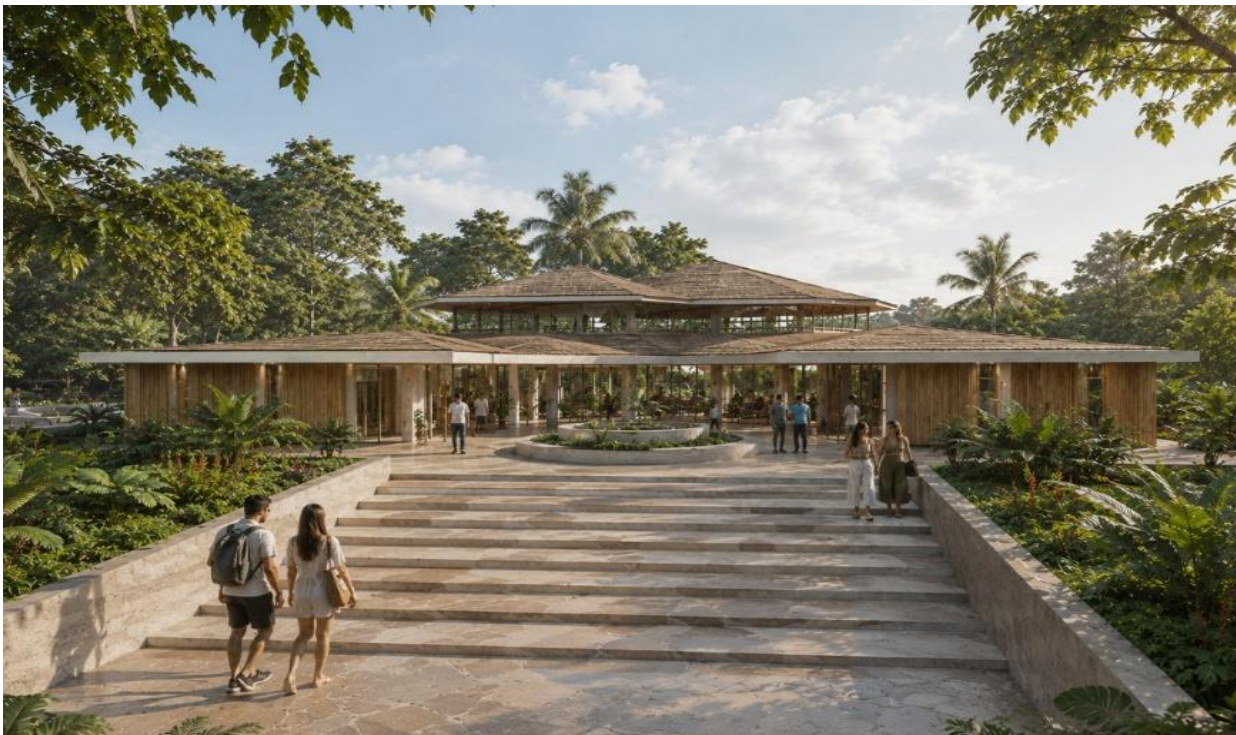
Figura 53. Vista de Modulo de Administración
