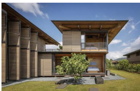
Figura 5 Vivienda con sistema de apertura tipo persianas
