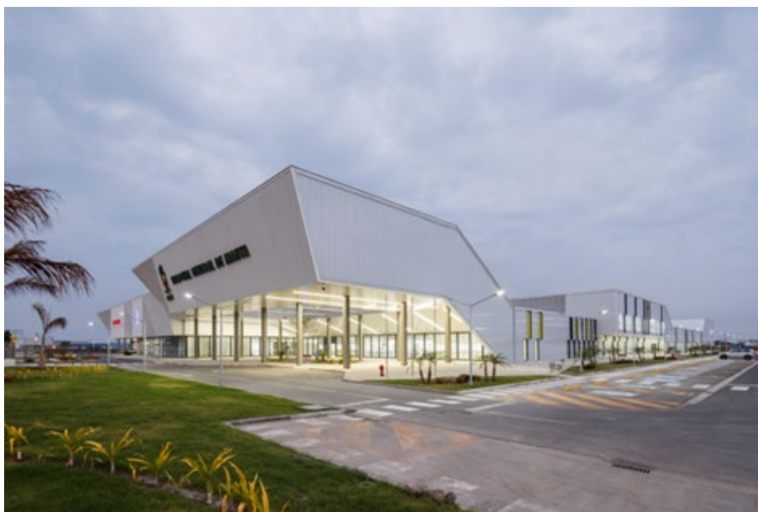
Figura 3. Vista general del Hospital Manta – PMMT, Ecuador. Fuente: PMMT Arquitectos, 2018.
