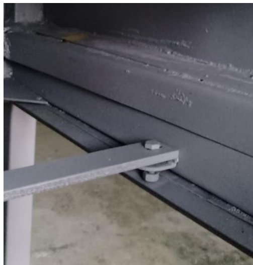
Figura 21. Acoplamiento estrella-cabina. Fuente: Gavilánez y Villafuerte (2025)
