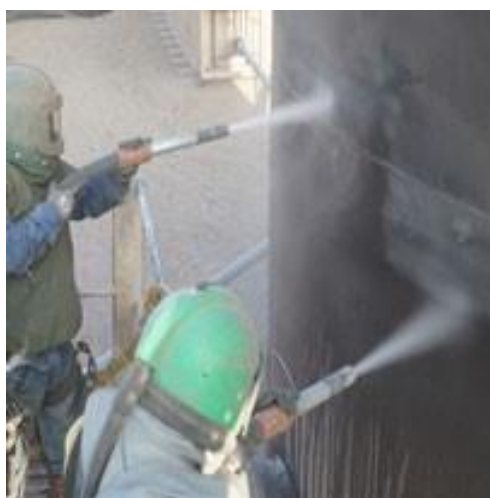
Figura 11. Limpieza con chorro abrasivo ráfaga Fuente: https://www.ocitrime.com.mx/
