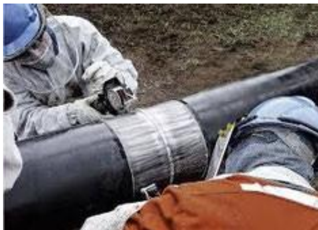
Figura 10. Limpieza con herramientas manuales mecánicas Fuente: //www.ocitrimex.com.mx
