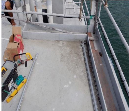
Figura 16: Selección del espacio destinado para la instalación de los paneles solares
