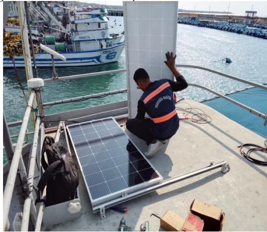
Figura 19: Instalación de los paneles solares en la estructura
