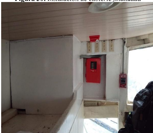
Figura 30: Instalación de cubierta finalizada
