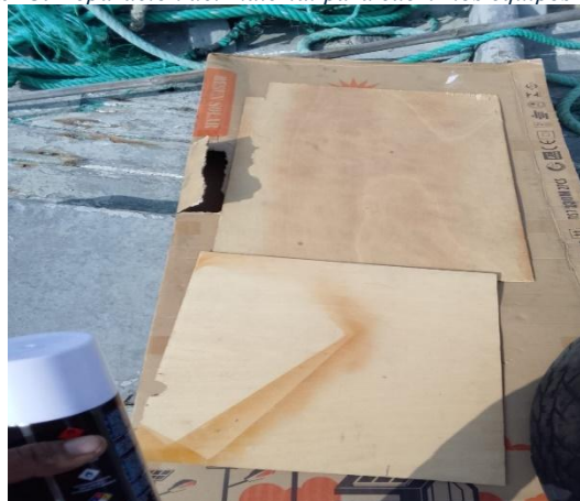
Figura 28: Preparación del material para cubrir los equipos electrónicos
