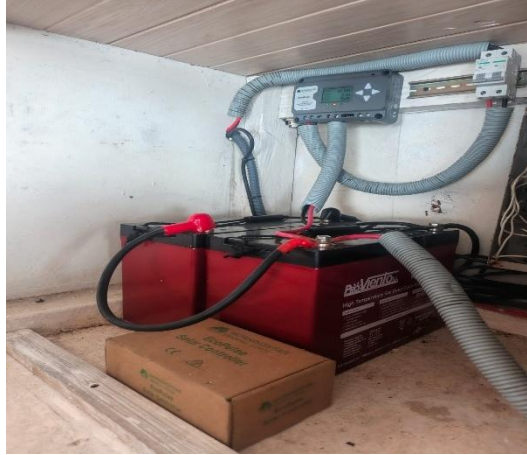
Figura 27: Instalación de tubos corrugados flexibles para la protección del cableado eléctrico
