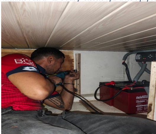
Figura 29: Instalación del armazón de protección para los equipos electrónicos
