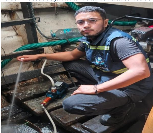
Figura 33: Pruebas de funcionamiento con una bomba de 110V
