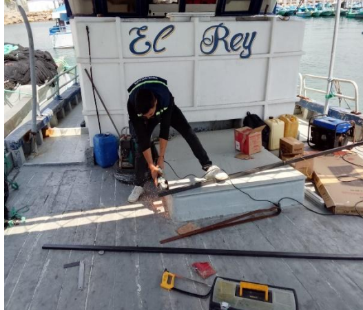
Figura 18: Preparación de los perfiles para los soportes
