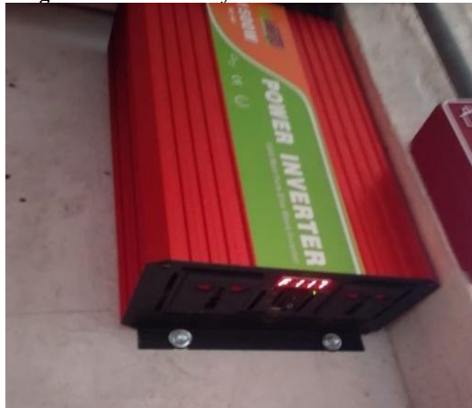
Figura 26: Pruebas de funcionamiento del inversor
