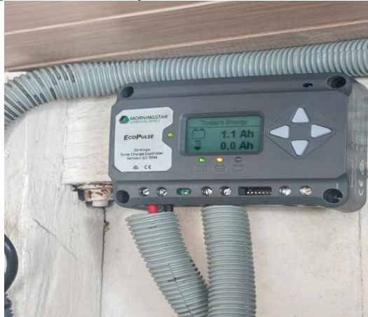
Figura 23: Instalación y conexión de un controlador de carga
