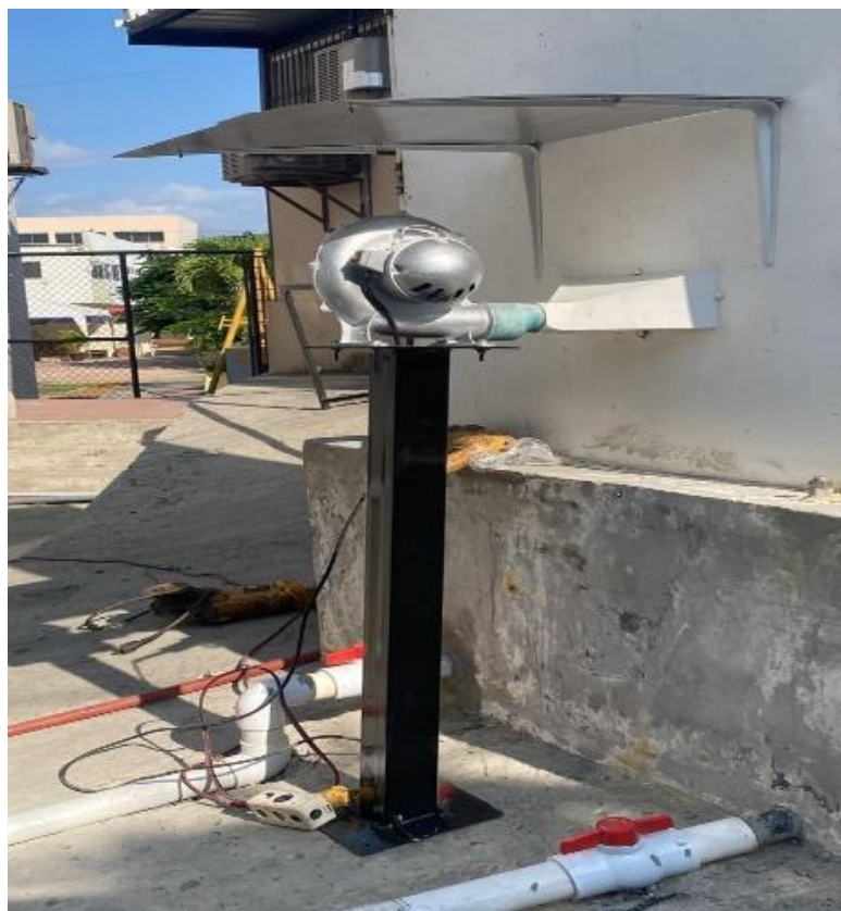
Colocación y adaptaciones al blower con su base respectiva y techado nuevo y acoples para la entrada del blower a la torre. Fuente: Elaborado por los autores.
