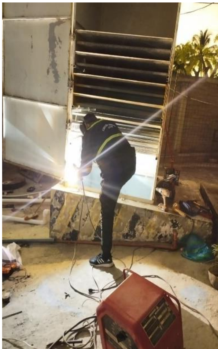
Soldadura de bisagras a la puerta de la torre (cambio el sistema de abertura de la puerta). Fuente: Elaborado por los Autores.
