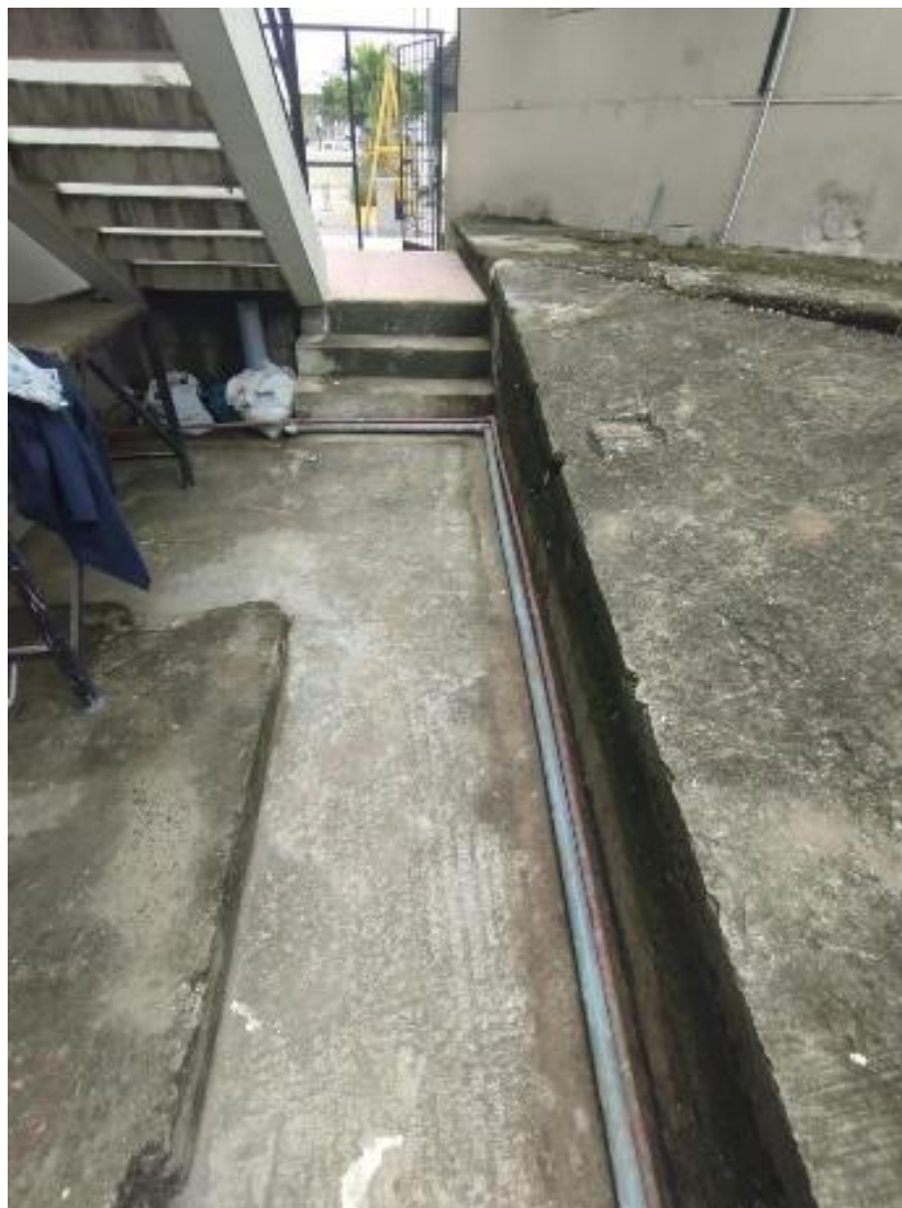
Limpieza de área de las tuberías de entrada y salida de la torre. Fuente: Elaborado por los Autores.
