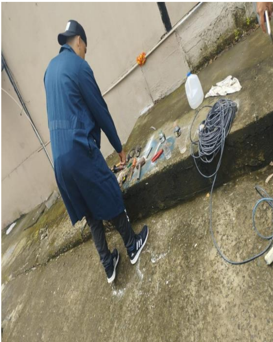
Limpiezas de las herramientas de trabajo para la torre. Fuente: Elaborado por los autores
