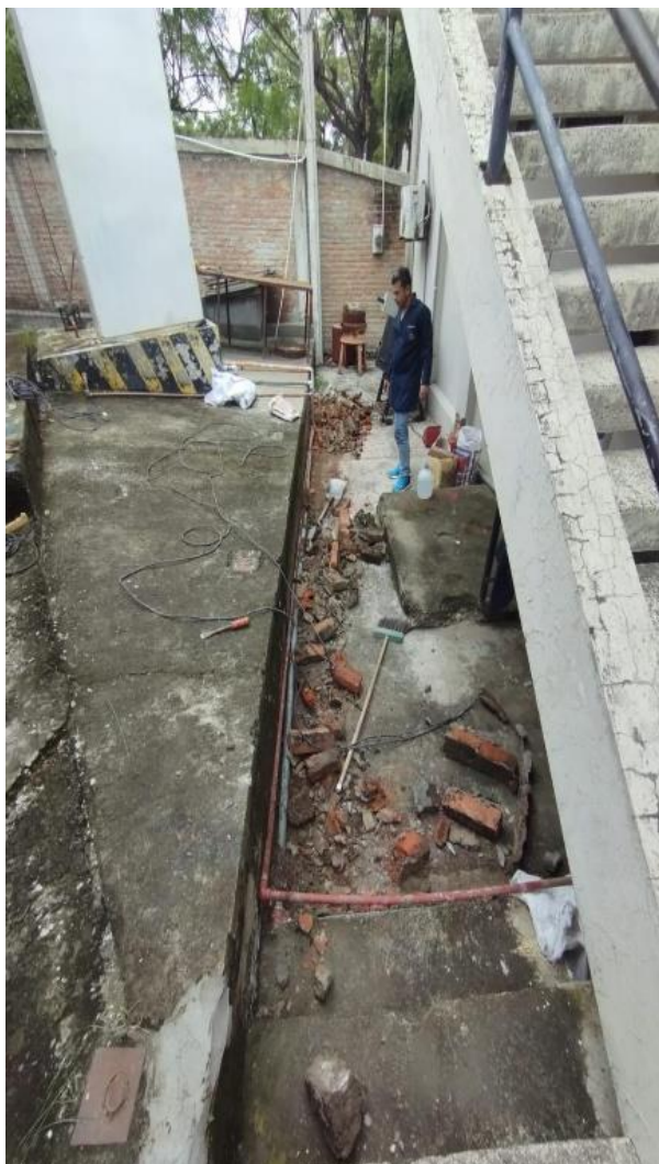
Desmonte de recubrimiento de las tuberías de agua fría y agua caliente. Fuente: Elaborado por los autores
