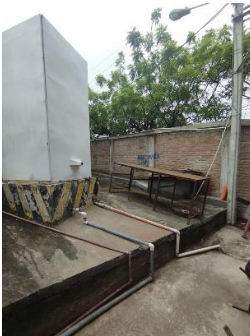
Limpieza del área de la torre de las salidas de agua fría caliente y desfogue. Fuente: Elaborado por los autores.
