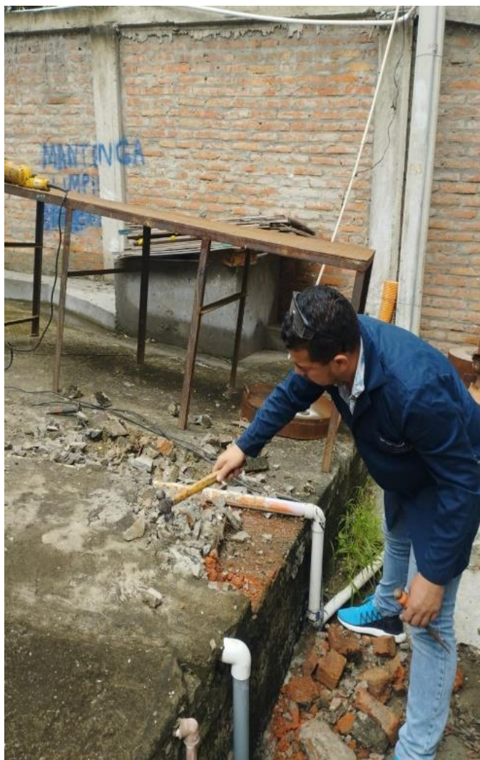
Retiro del piso cuarteado de las tuberías de agua de entrada y de desfogue. Fuente: Elaborado por los Autores
