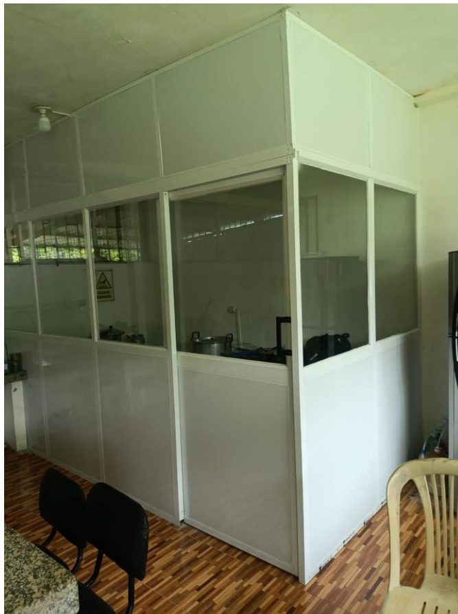
Ilustración 12. Instalación del vidrio templado para el aislamiento
