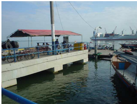
Muelle de embarque de pasajeros a Jambelí ubicado en Puerto Bolívar
