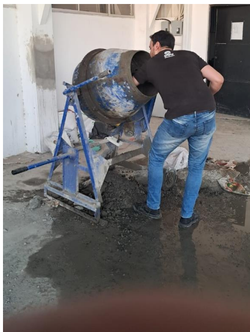
Anexo 17 Limpieza de concretera
