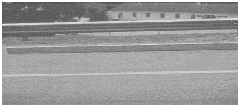
Figura 1.15. Tipo de Falla Corrugación – Nivel de severidad Bajo. Tomado de PAVEMENT MANAGEMENT FOR AIRPORTS ROADS AND PARKING LOTS- (Segunda ed.), por Shahin, 2005.
