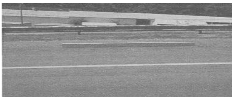
Figura 1.16. Tipo de Falla Corrugación – Nivel de severidad Medio.
