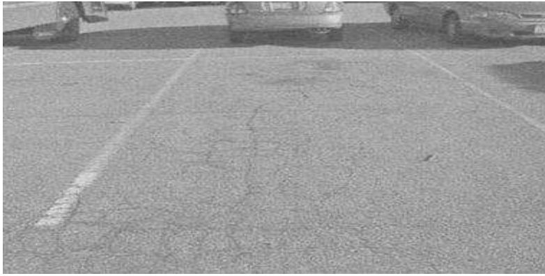
Figura 1.4. Tipo de Falla piel de cocodrilo – Nivel de severidad Medio.
