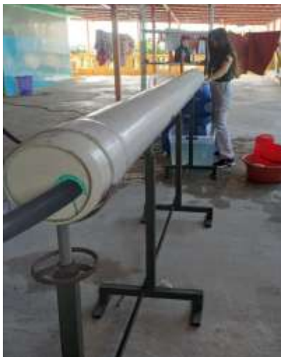
Figura 7 Soporte metálico de la tubería
