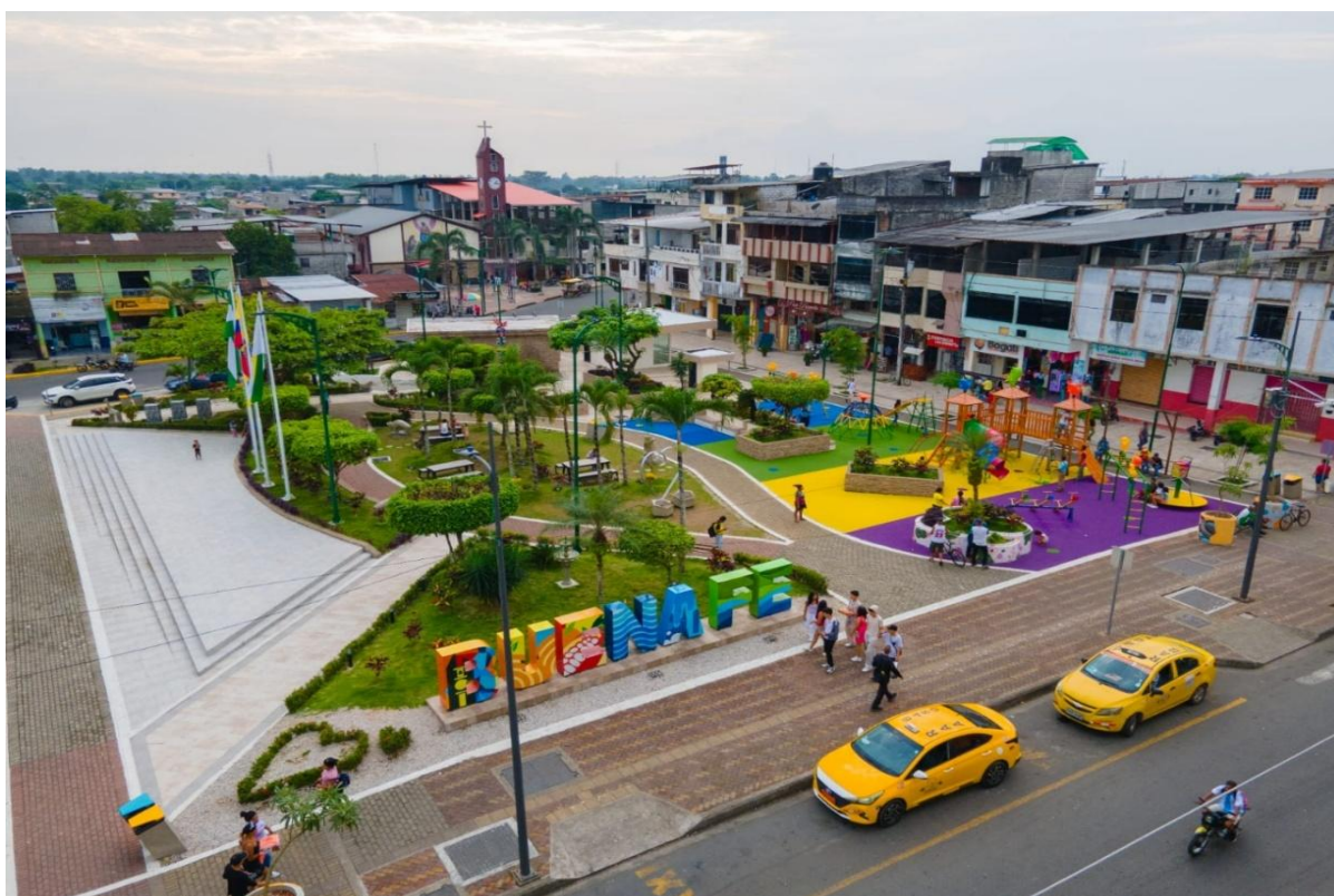
Ilustración 14: Parque Central de Buena Fe: estado posterior a la reconstrucción, vista del borde peatonal sobre la Av. 7 de agosto.
