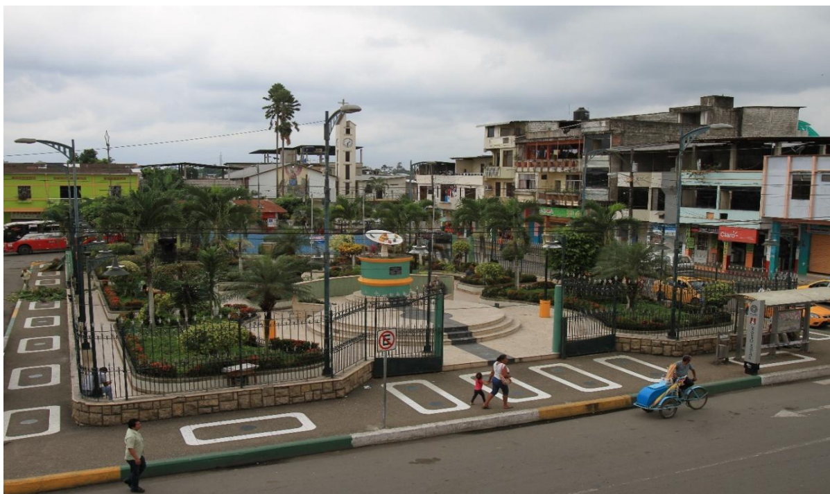
Ilustración 13: Parque Central de Buena Fe: estado previo a la reconstrucción (condición anterior del borde peatonal).
