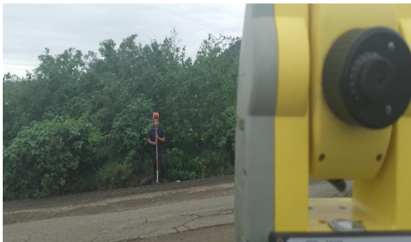
Figura 4 Tomando punto con la estación total
