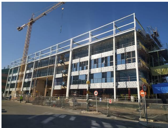
Ilustración 3. Reforma estructural de Edificio
