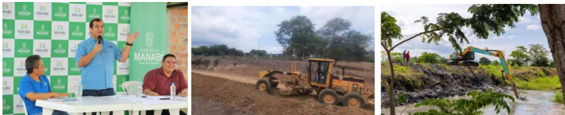
Ilustración 1: Registro fotográfico referencial del caso de estudio.
