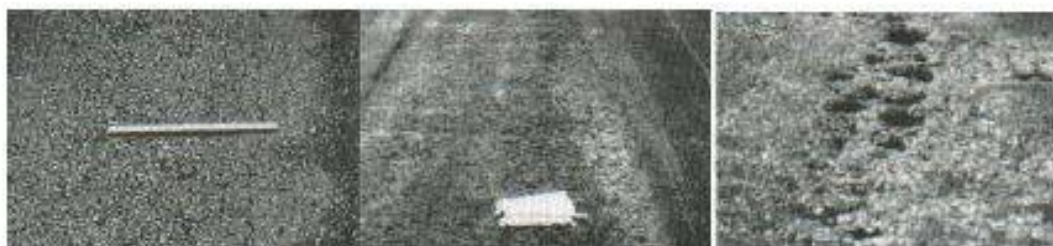
Figura 24: Falla por meteorización de baja, media y alta severidad, de izquierda a derecha
