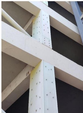
Ilustración 3 Encamisado de acero en el edificio de rectorado en ULEAM.
