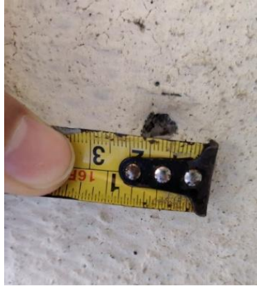
Ilustración 14 Perforación de 0,75cm de diámetro en la columna B1.
