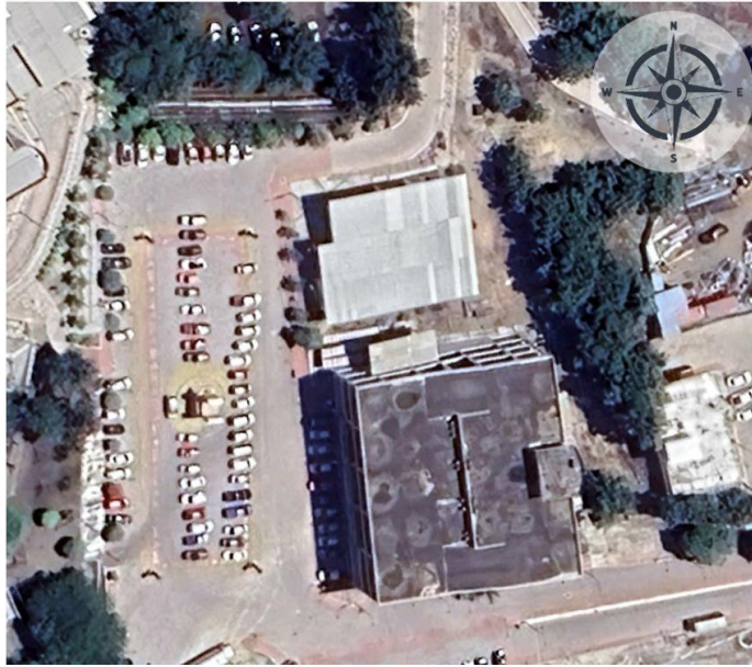
Ilustración 7 Vista superior del edificio de Rectorado de la ULEAM. Fuente: Google Earth.
