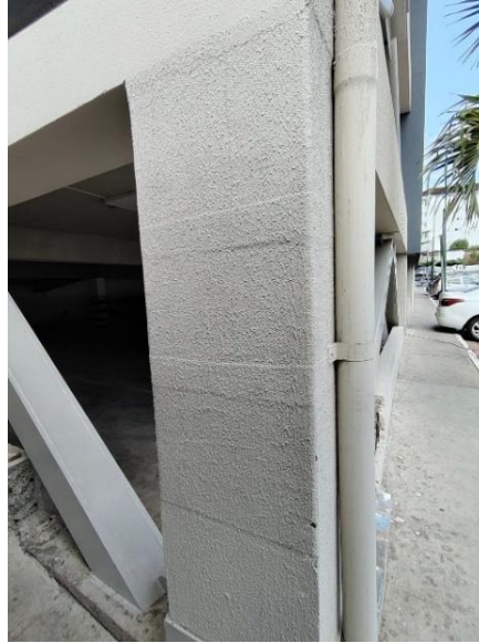
Ilustración 17 Reforzamiento con FPR en la planta baja, columna A1
