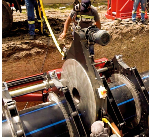
Ilustración 17 termofusión de tubería catálogo RIVAL (RIVAL, s.f.)
